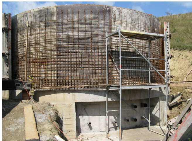
Így készült a 200 m 3 -es vasbeton tartály
